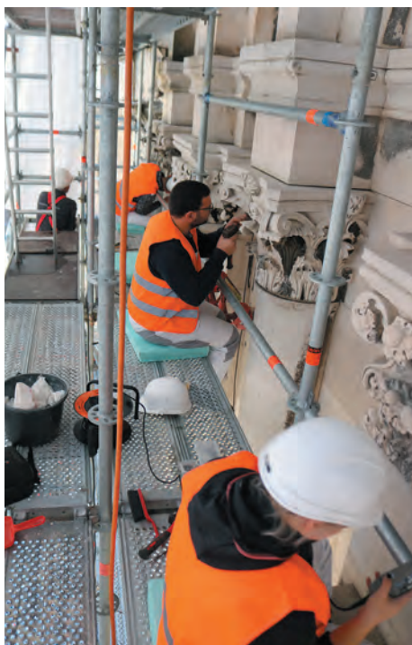
Mehaničko čišćenje skrame na arhitektonskoj skulpturi zvonika
