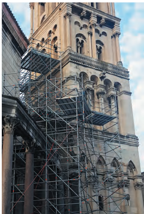
Pogled na zvonik tijekom konzervatorsko-restauratorskih radova
