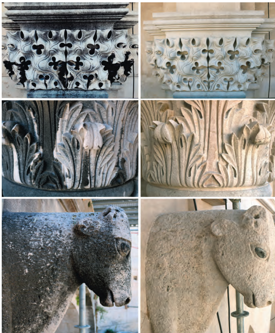
Detalji arhitektonske plastike zvonika prije i poslije čišćenja
