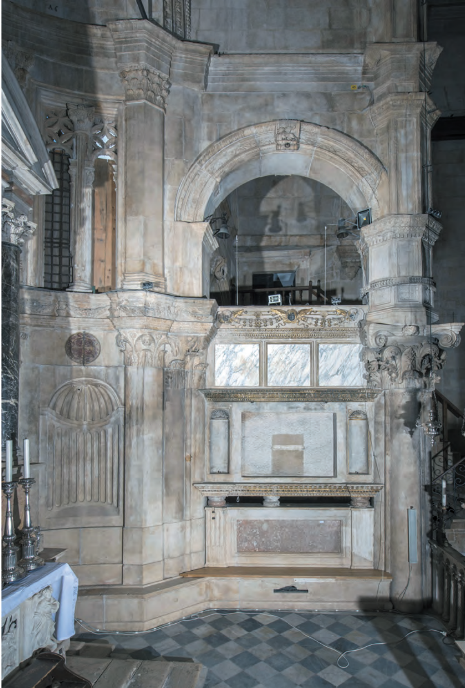
Južni pregradni zid središnje apside svetišta katedrale sv. Jakova u Šibeniku, stanje tijekom konzervatorsko-restauratorskih radova (Arhiv Hrvatskog restauratorskog zavoda)
