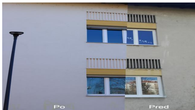
Slika 1: Usporedba izgleda fasade prije i nakon energetske obnove.
