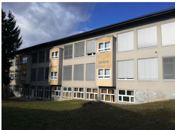
Slika 2: Fasada škole prije energetske obnove,
