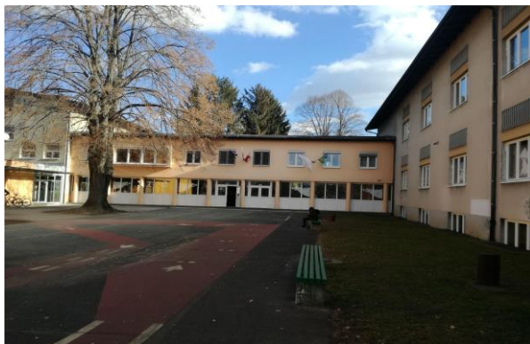
Slika 4: Ulaz u zgradu prije energetske obnove,
