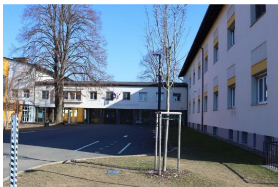
Slika 5: Ulaz u zgradu nakon energetske obnove.
