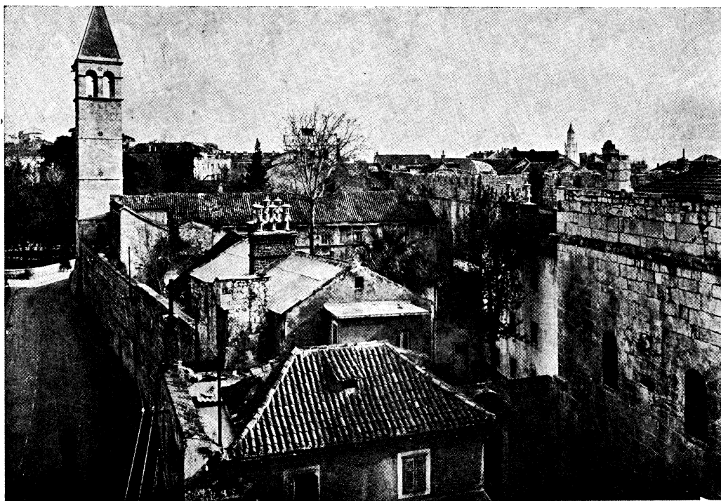
1. Porušeni sklop Vojne bolnice u Splitu
