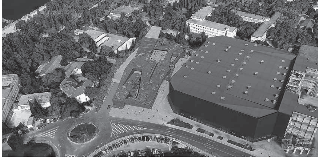
sl.6. Muzejska zgrada, Lora, pogled iz zraka
