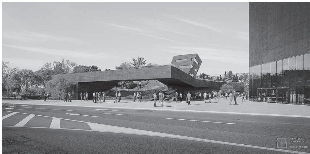
sl.5. Muzejska zgrada, Lora, pogled s prometnice
