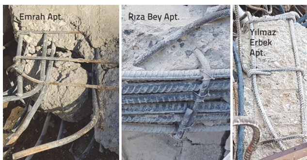
Slika 34. Vrste armature primijenjene u gradnji urušenih zgrada
