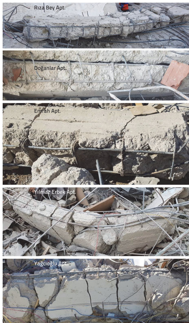
Slika 36. Detalji armiranja stupova i greda urušenih zgrada
