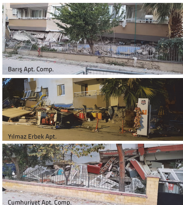
Slika 38. Zgrade koje su se urušile zbog otkazivanja stupova prizemlja
