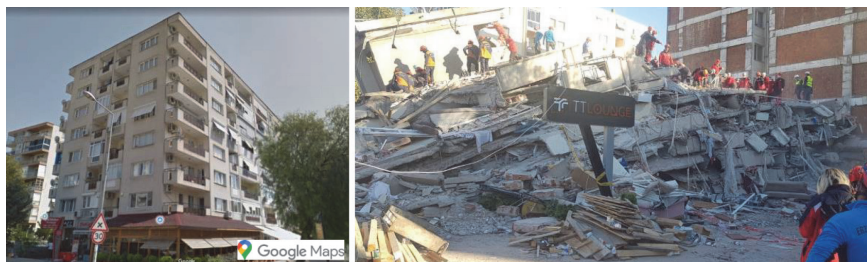
Slika 22. Fotografije stambene zgrade Doğanlar prije i poslije potresa
