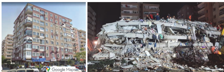
Slika 21. Fotografije stambene zgrade Rıza Bey prije i poslije potresa
