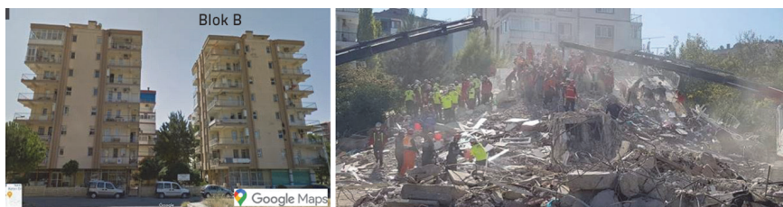
Slika 24. Fotografije bloka B stambenog kompleksa Yağcıoğlu prije i poslije potresa
