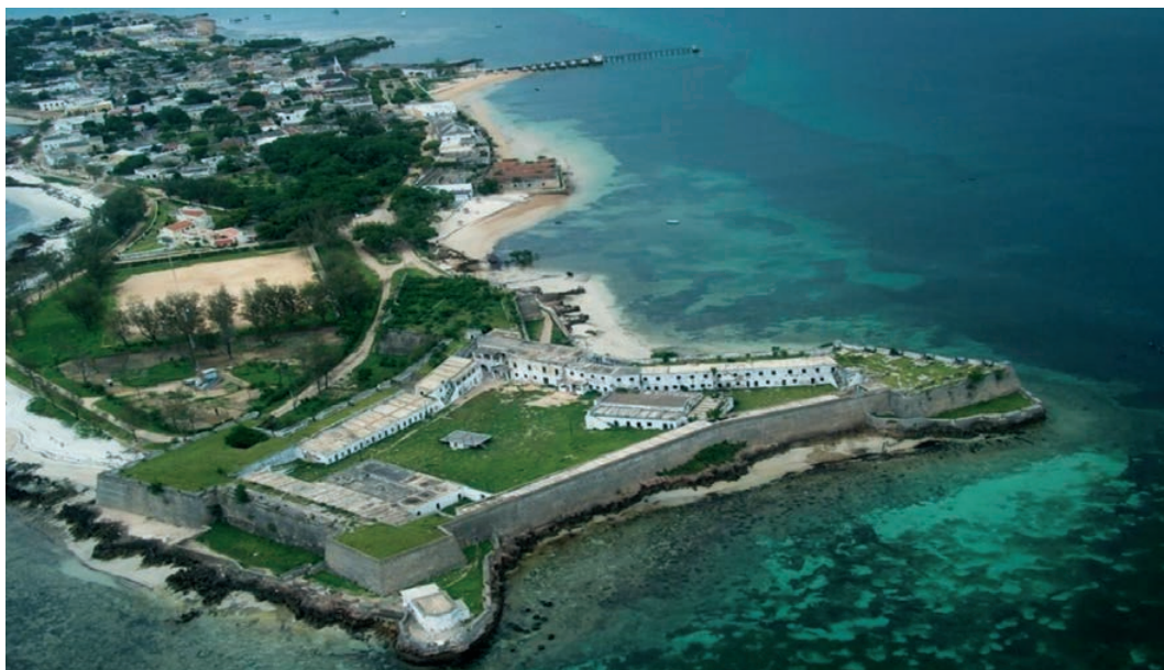
Sl. 2. Tvrđava São Sebastião na otoku Mozambiku
