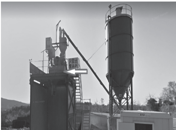
Slika 1. Betonara, mjesto ozljede
