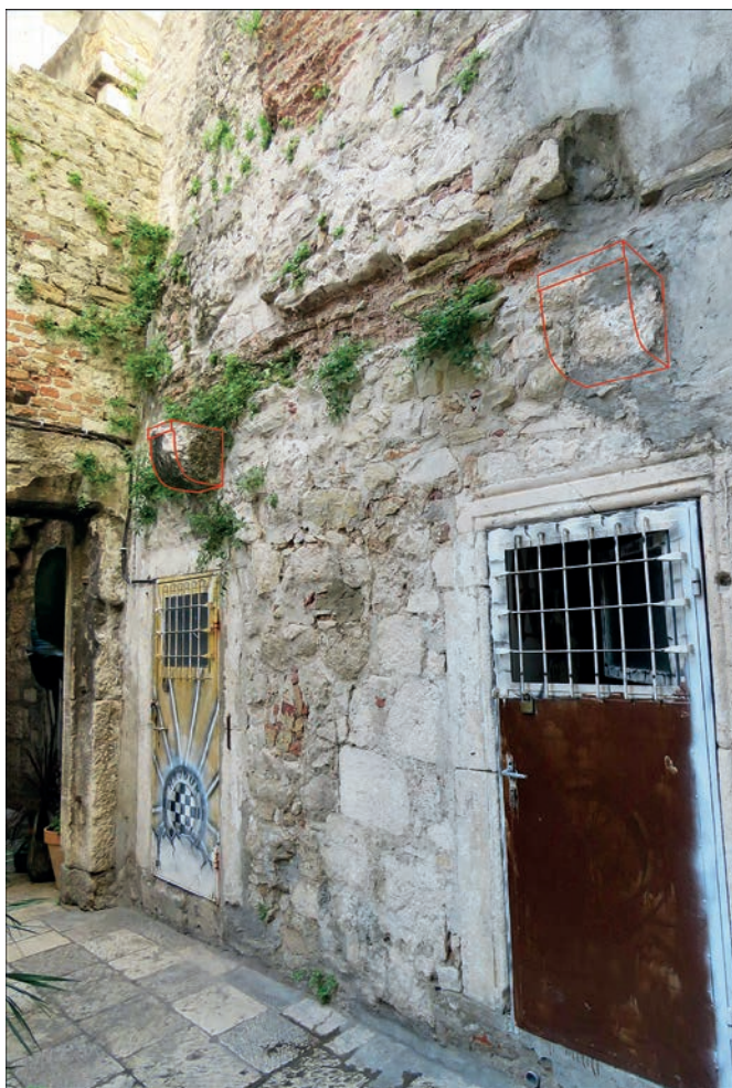
Sl. 13. Originalne antičke konzole u prvom cubiculu sjeverno od zapadnih vrata koje su nosile drvenu međukatnu konstrukciju (foto: K. Marasović)
