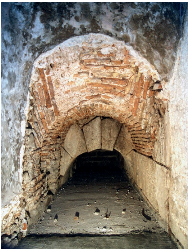
Sl. 11. Prostorija ispod antičkog svoda gornjeg kraka stubišta sjeverno od zapadnih vrata Palače (foto: K. Marasović)
