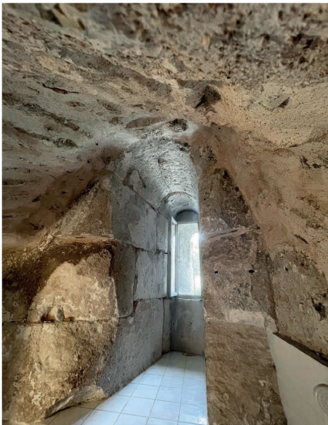
Sl. 7. Prozor prvog kraka antičkog stubišta u sjevernom zidu Palače u sklopu samostana sv. Martina (foto: Ž. Bačić)
