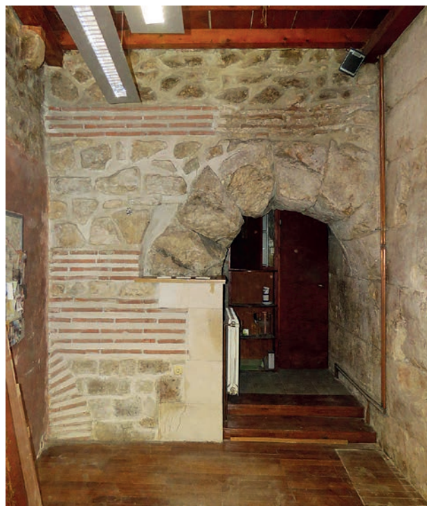
Sl. 6. Ostaci antičkih vrata s jednstrukim lukom od opeke kojima se pristupalo gornjem kraku antičkog stubišta u sklopu samostana sv. Martina (foto: K. Marasović)
