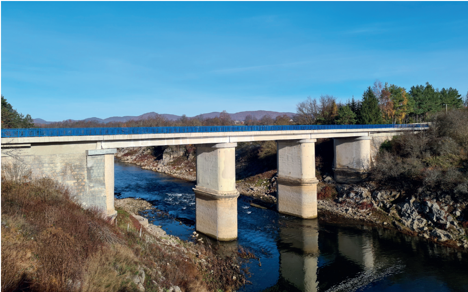
Slika 13. Budački most – pogled s lijeve obale na uzvodnoj strani (Foto V. Šulentić, 19. 11. 2021.)
