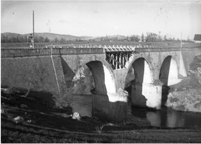
Slika 9. Oštećenje čeonog zida sanirano drvenom konstrukcijom, fotografija prof. Ivana Rubčića, druga pol. 1930-ih (Izvor: Hrvatski školski muzej, SN-480)
