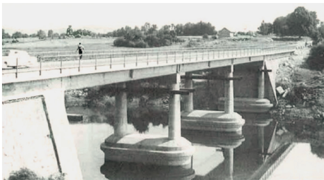
Slika 11. Betonski most osamdesetih godina prošlog stoljeća (Izvor: Radić, J., 2003., str. 174.)
