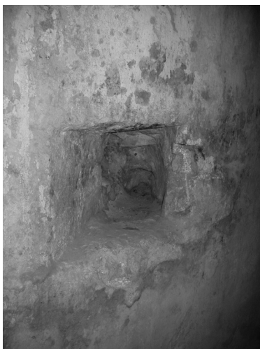
Sl. 2.a Puškarnica u zapadnom zidu zvonika samostana
