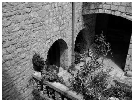
Sl. 8. Ostatci prvog trijema klaustra (1720.-1730.)
