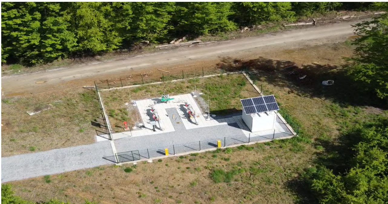
Slika 8. Zračna snimka plinskog čvora na mjestu priključka plinske stanice Grubišno Polje na plinovod Virovitica – Kutina
