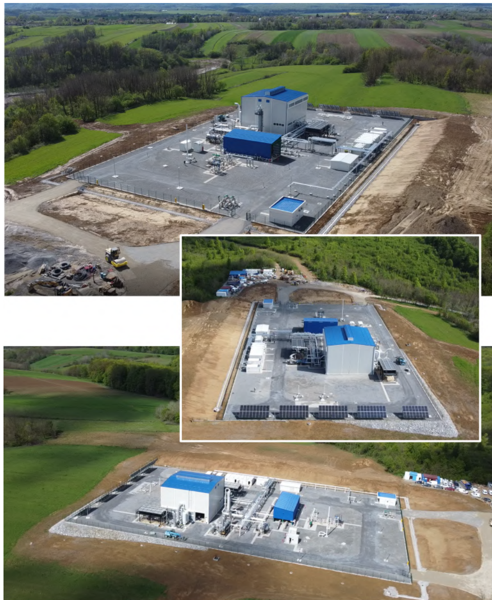
Slika 7. Zračna snimka izgrađene plinske stanice na lokaciji Grubišno Polje
