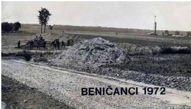
Slika 3. Prvi zemljani radovi na budućim objektima sabirnog sustava Beničanaca
