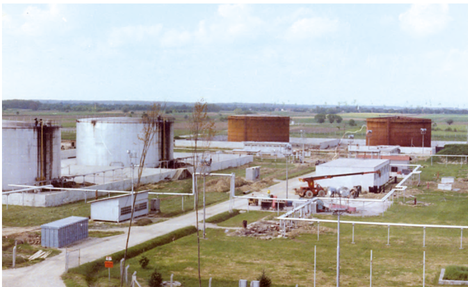
Slika 7. Radovi na izradnji otpremne stanice Beničanci
