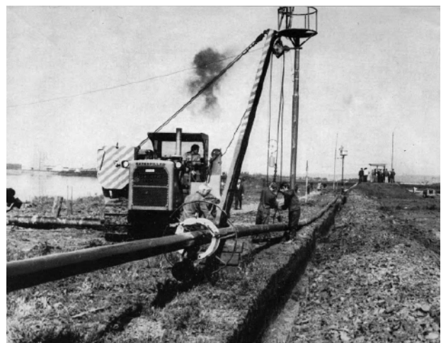
Slika 4. Gradnja naftovoda u slavonskoj ravnici
