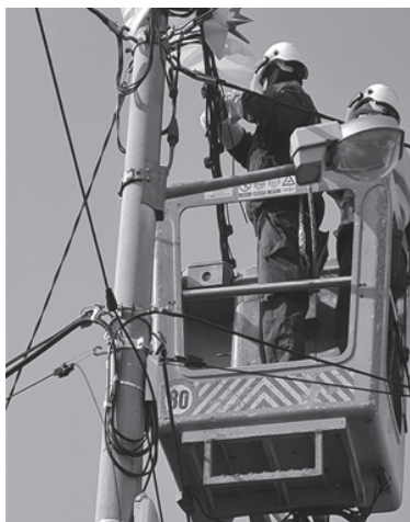
Slika 1. Rad pod naponom prilikom izrade priključaka korisnika elektrodistribucijske mreže
