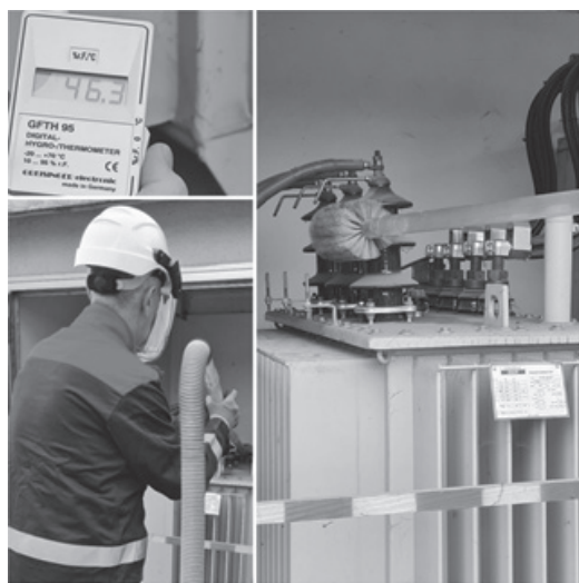
Slika 2. Rad pod naponom na TS 10(20)/0,4 kV uporabom usisavača
