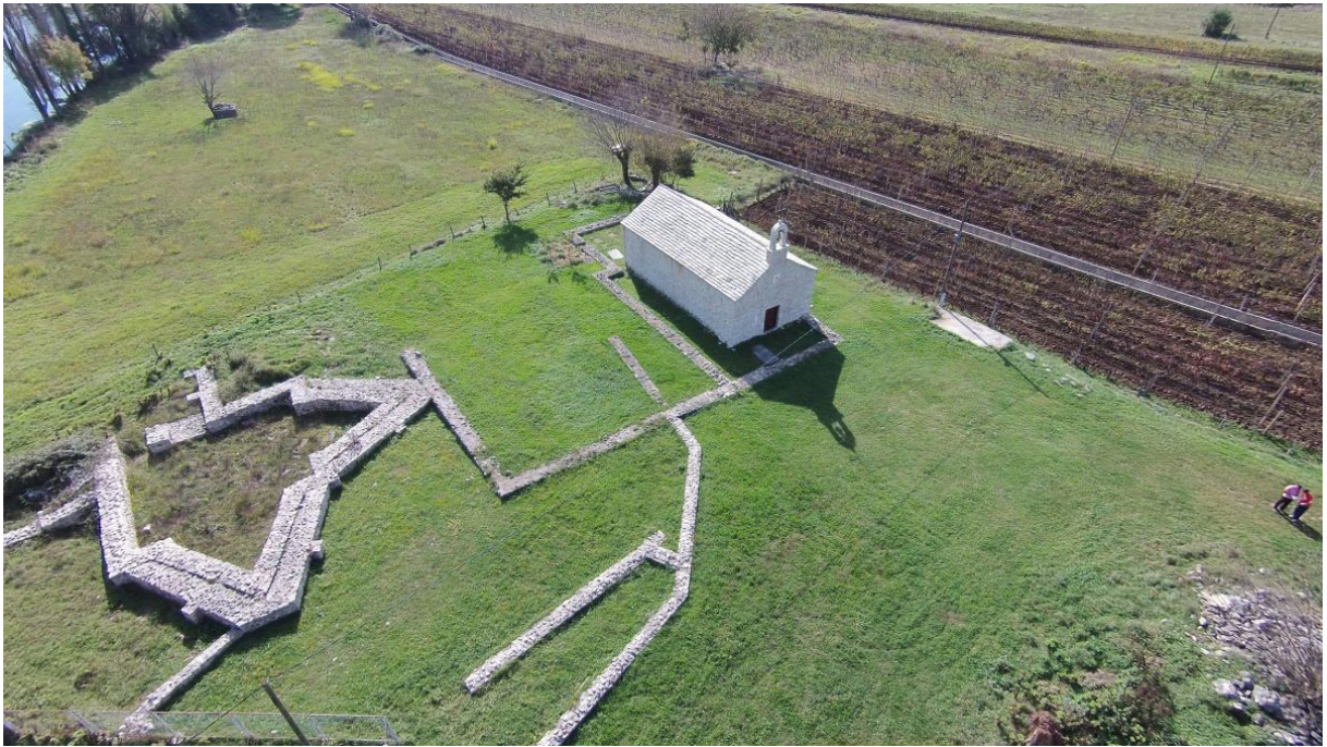
Sl. 8. Lokalitet nakon završenih radova (slikano bespilotnom letjelicom) Fig. 8 Site after completed works. (Drone image)
