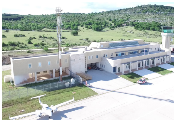
Slika 1 Nova putnička zgrada Aerodroma Brač [12]
