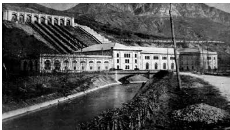
Foto esterno centrale idroelettrica "Antonio Pitter" di Malnisio, Montereale Valcellina (PN), 1900-1905.
