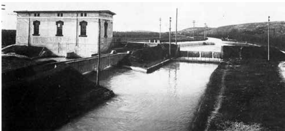
Centrale idroelettrica di Ronchi, Officine Elettriche dell'Isonzo, (GO), 1907. Collezione S. Vittori.
