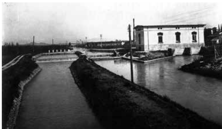
Centrale idroelettrica di Fogliano, Officine Elettriche dell'Isonzo, (GO), 1907. Collezione S. Vittori.
