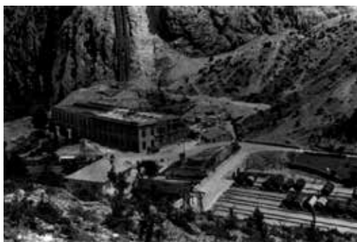
Lavoro realizzazione impianto idroelettrico di Kraljevac, Croazia 1908-1912.
