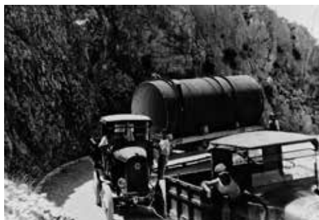
Lavoro realizzazione impianto idroelettrico di Kraljevac, Croazia 1908-1912.
