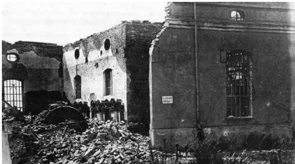
Centrale elettrica di Monfalcone, Officine Elettriche dell'Isonzo, bombardata (GO), 1916. Collezione S. Domini.
