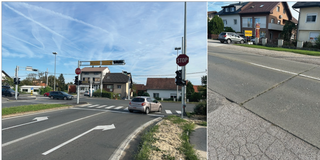
Sl. 2. Semafor postavljen 1986. godine, ali ne radi kako se ne bi stvarale prometne gužve kod isključivanja s autoceste na izlazu Kraljevečki Novaki (lijevo); Dugoselska cesta izgrađena 1936. godine od betonskih blokova (desno).
