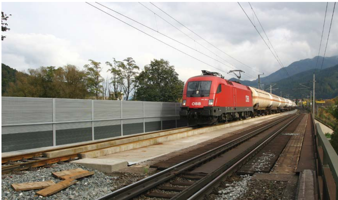
Slika 15. Kolosijek 2 mosta na Muri koji je obnovljeni radi smanjenja razine buke
