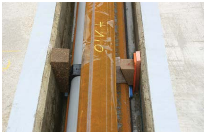
Slika 9. Fiksiranje položaja tračnice u kanalu
