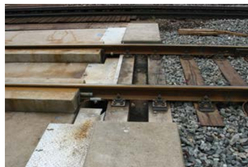
Slika 11. Prijelazna konstrukcija, zapadni upornjak (strana Leobena)
