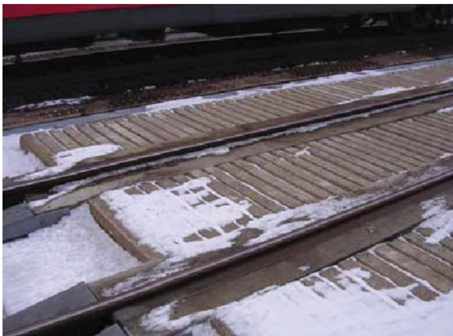
Slika 12. Prigušni podložni paneli koji se koriste kao dodatna akustična mjera obnove
