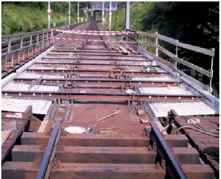
Slika 5. Ugradnja čeličnih odsječaka (gornji pojas) za kolosijek na čvrstoj podlozi
