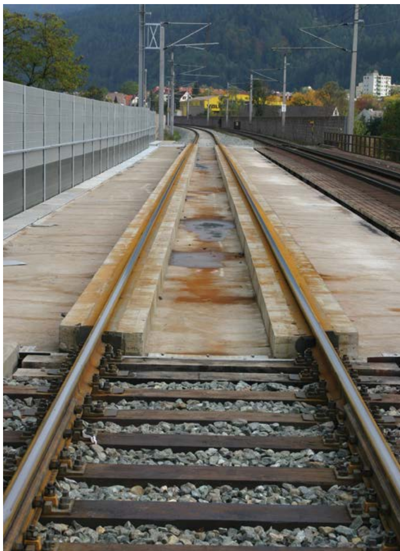
Slika 14. Nosači kolosijeka s ERS-om i bukobran nakon obnove, gledajući na istok Izvor: autor
