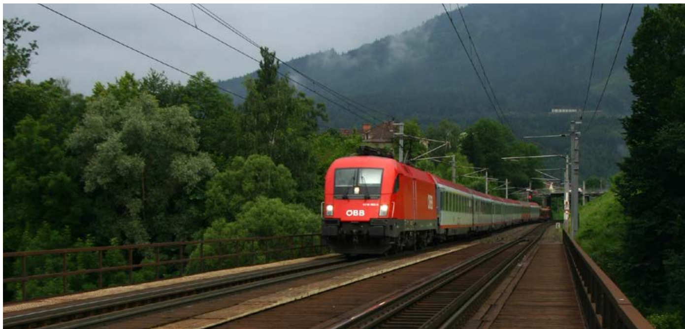
Slika 1. Most preko rijeke Mure u Leobenu prije obnove
