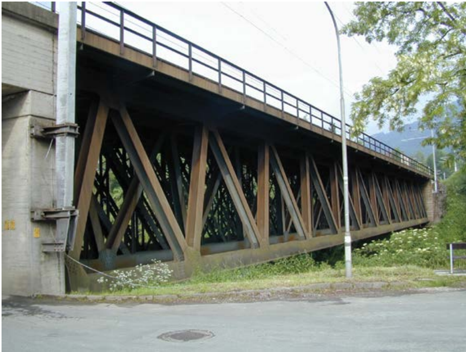
Slika 2. Čelično-rešetkasta konstrukcija mosta
