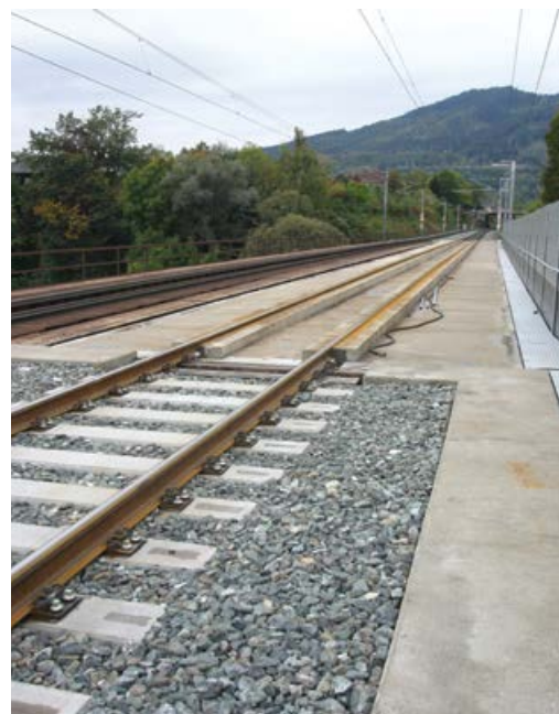
Slika 10. Prijelazna konstrukcija, istočni upornjak (strana Brucka)
