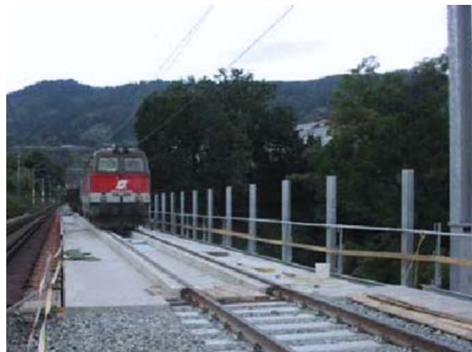
Slika 13. Mjerna kompozicija vlaka prolazi kolosijekom bez zastorne prizme s ERS-om
