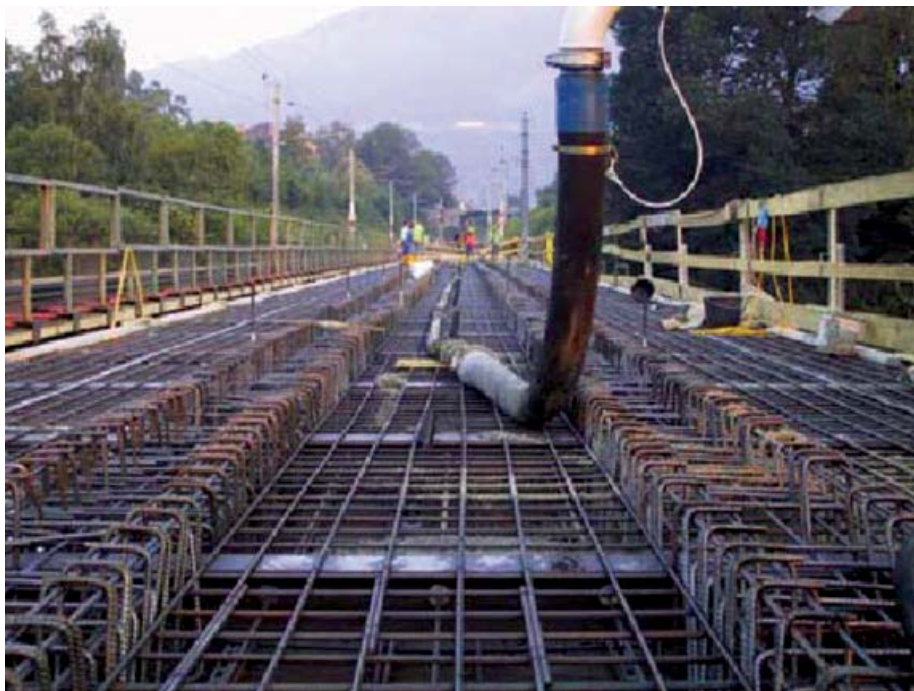
Slika 6. Armaturni koš kolosijeka na čvrstoj podlozi
