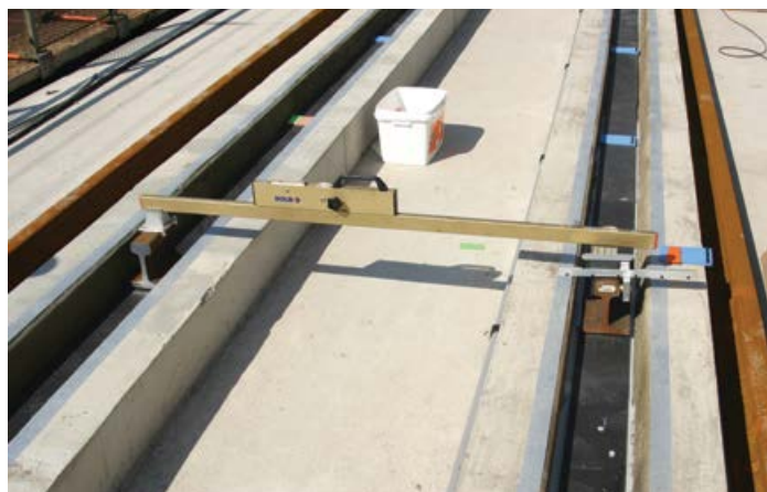
Slika 8. Poravnanje vrha tračnice prema zahtijevanome položaju
