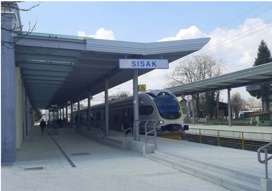
Slika 6. Kolodvor Sisak po završetku radova
