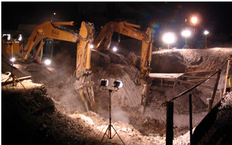
Slika 4. Pikamiranje prilikom iskopa za pothodnik Gospić
