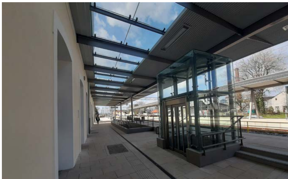
Slika 1. Dizalo namijenjeno osobama smanjene pokretljivosti – nakon rekonstrukcije kolodvora Sisak 2020.
