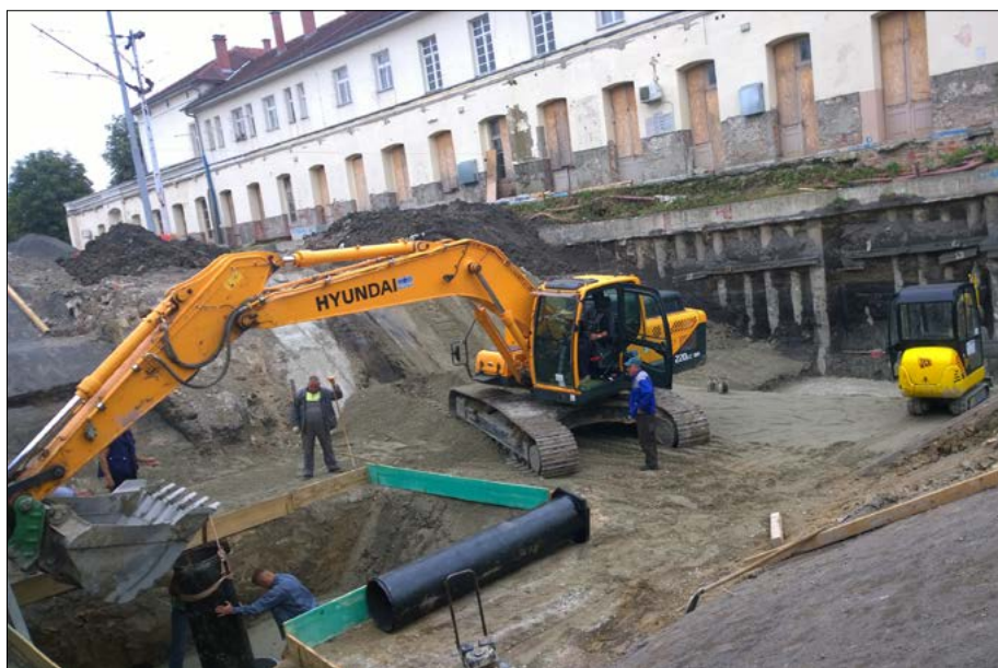
Slika 5. Iskop za pothodnik u kolodvoru Sisak sa zaštitom građevinske jame
