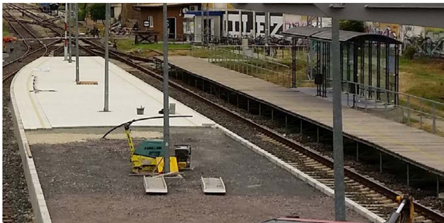
Slika 2. Primjer privremenoga perona tijekom radova
