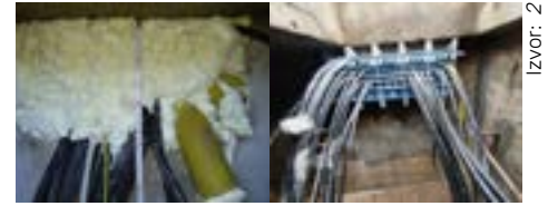
Slika 7. Sanacija prodora kabela
