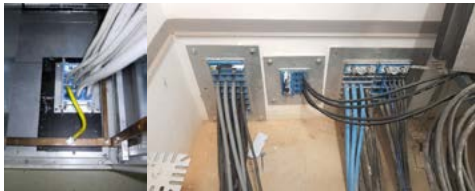
Slika 1. Primjena modularnoga sustava brtvljenja
