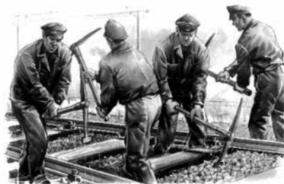
Slika 1. Ručno podbijanje, izvor: [10]
