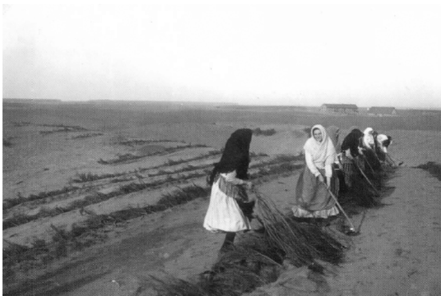
Slika 7. Radovi na pošumljavanju Peskov. Izvor: KRANJČEV, Radovan. Pijesci u Podravini: Đurđevački pijesci, Đurđevac, 2006.
