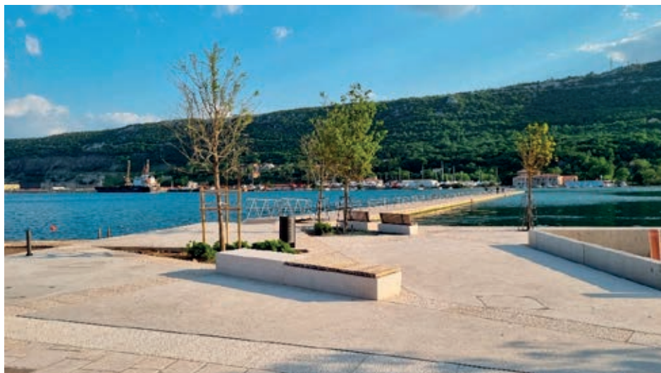
Slika 10. Uređenje priobalnog područja uz sjeveroistočni kraj podmorskog tunela u Bakru, pogled prema plutajućoj šetnici
