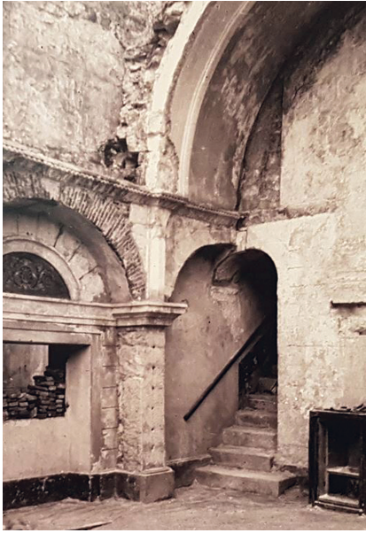
Fig. 9. Zara, monastero di Santa Maria, sala detta del Capitolo, dopo i bombardamenti.
