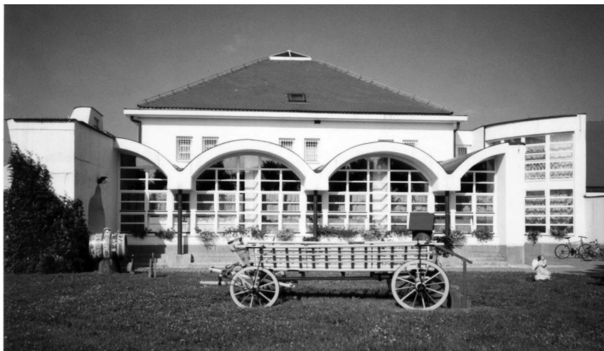
Zgrada novog vrtića
