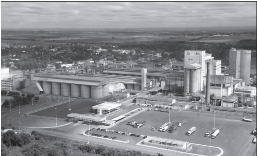
Prerađivački kompleks „Agrarie” u podunavskošvapskoj naseobini – koloniji Vitória – Entre Rios.
