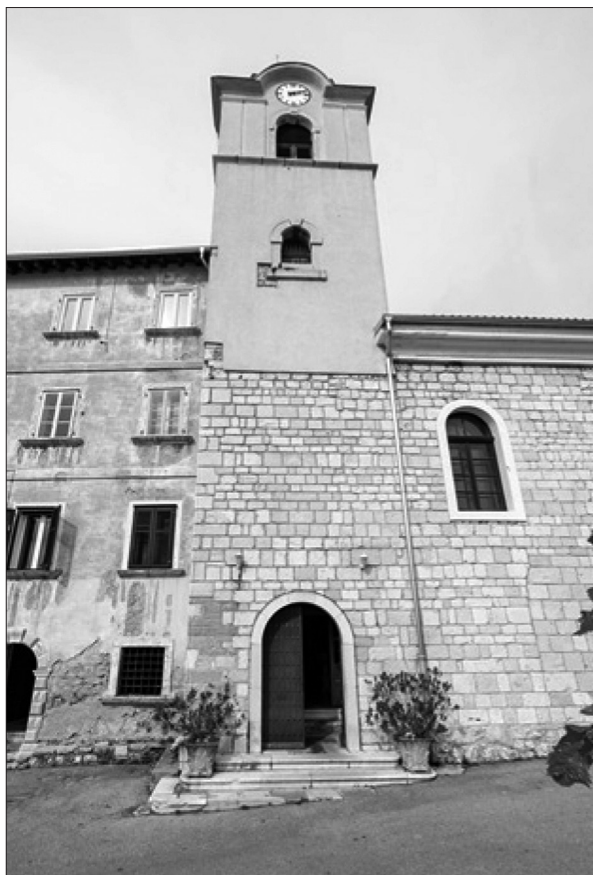
Sl. 7. Južno pročelje crkve sv. Nikole u Kraljevici (foto: N. Beg)
