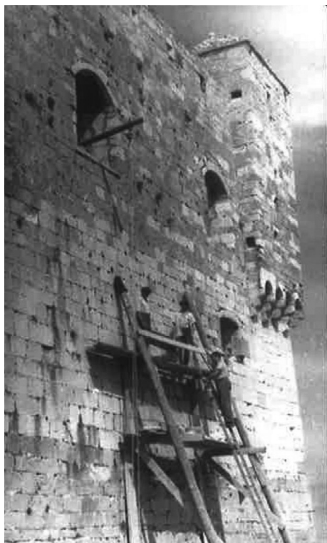
Sl. 6. Popravak oštećenja na tvrđavi Nehaj (izvor: Senj, stradanja u Drugom svjetskom ratu , 2010, 133)
