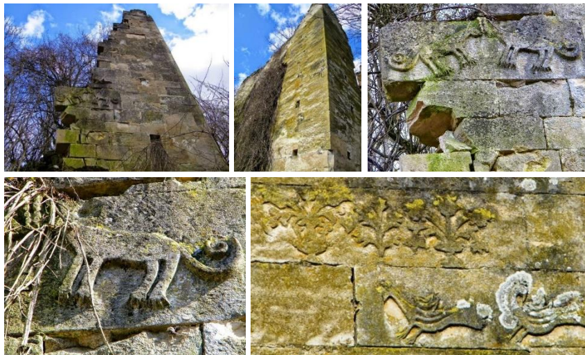
Slike 58.-62. Dobar primjer očuvanosti slatkovodnih vapnenaca miljevine u ostacima kule begova Čengića u selu Rataji kod Miljevine u istočnoj Bosni. Uz patinu, primjetna je prisutnost biološkog obraštaja u obliku mahovine, lišajeva i gljivica, (foto: Zaim Bešović, 2015.)
