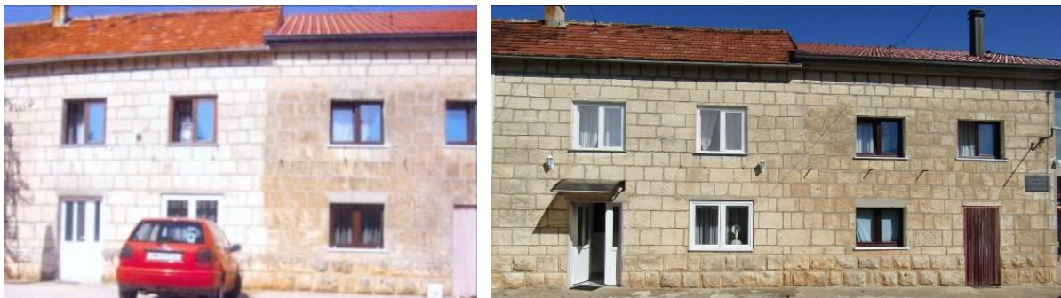
Slike 16.-17. Primjer skidanja sloja kamena s patinom s lijevog dijela fasade od (posuške) miljevine na kući Vinjanima kod Posušja posebnim alatom (kresom sa 3 zuba). Za 3 dana skinut je sloj debljine 8-10 mm sa površine od oko 50 m 2 , (lijevo, foto: F. Oreč, 2011.). Osam godina kasnije vidljiv je određeni povrat patine na tom dijelu kuće, (desno, foto: K. Šaravanja, 2019), [21]
