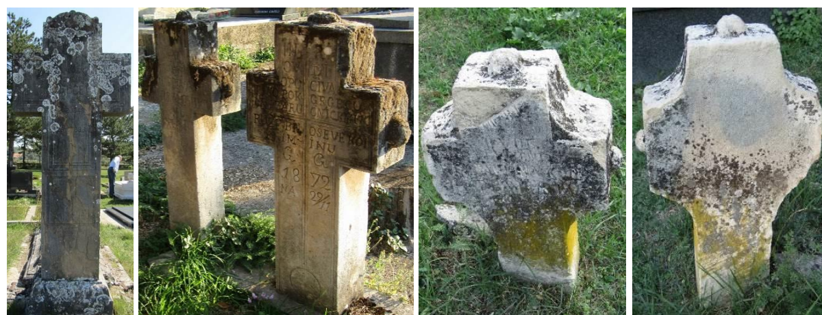
Slike 40.-43. Prekrivenost nadgrobnih spomenika od miljevine biološkim obraštajem u groblju sv. Ive u Livnu (lijevo) i u groblju Šoinovac u Mostaru u (ostale 3 slike); Biološki obraštaji (lišajevi, mahovina, gljivice,...) koriste kamen kao stanište ili/i hranu, (foto: K. Šaravanja), [21]
