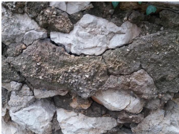
Slika 7. Odvajanje maltera
