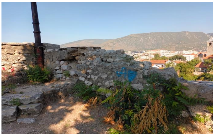
Slika 9. Odvajanje kamena
