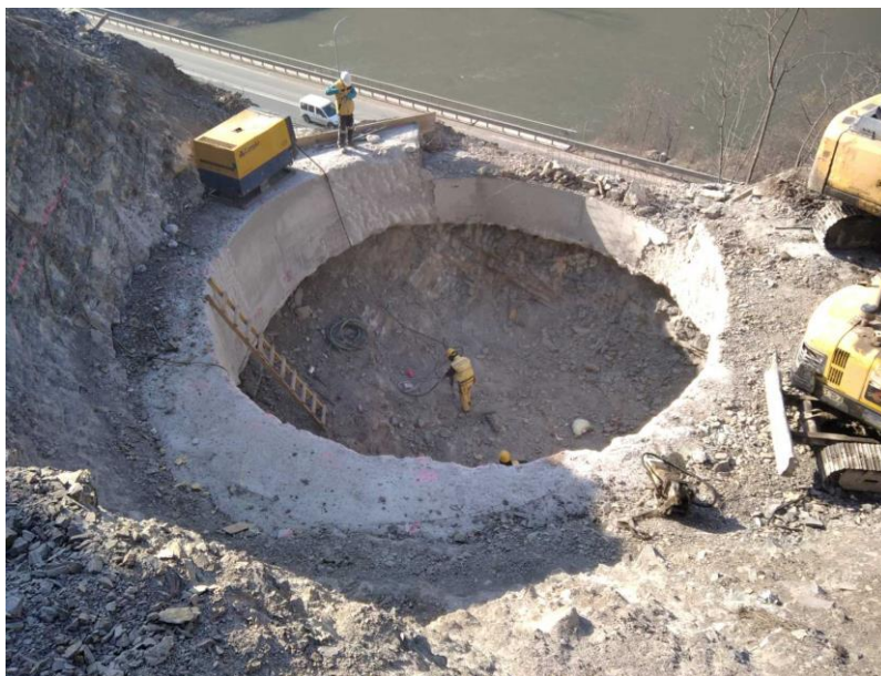
Slika 9. Bušenje minskih bušotina
