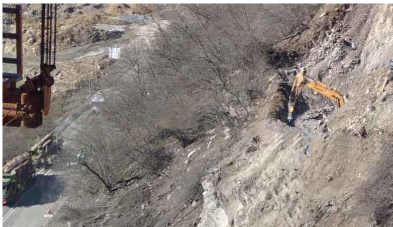
Slika 7. Prikaz prve faze radova kod iskopa stupnog mjesta S1D
