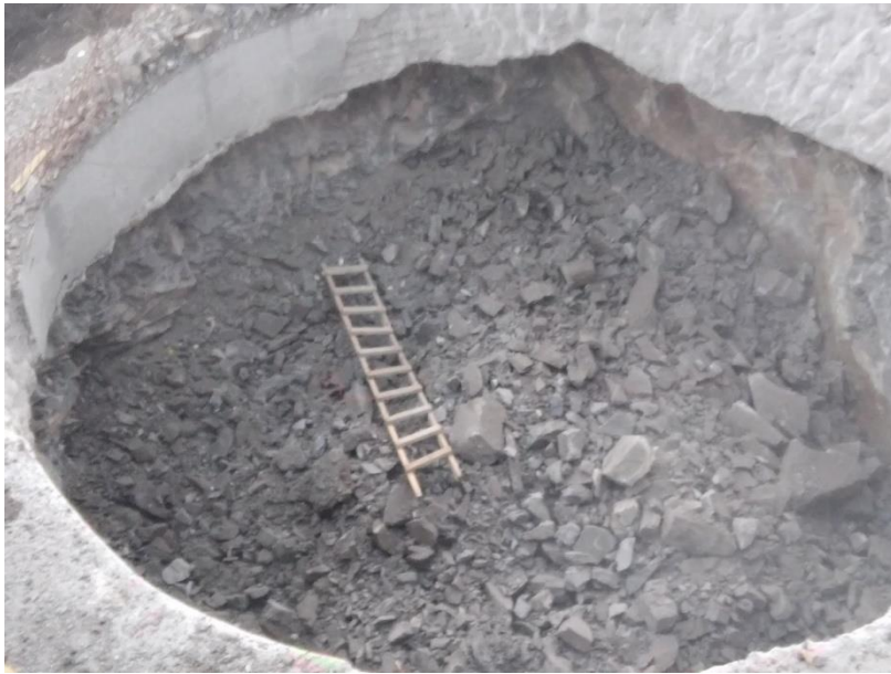
Slika 12. Prikaz minskog polja nakon miniranja
