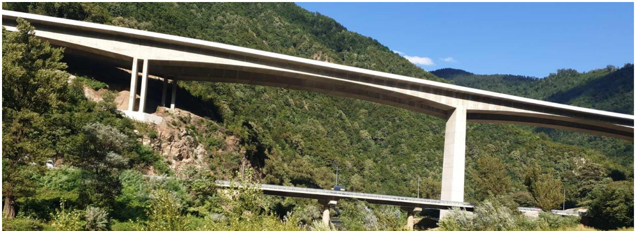
Slika 13. Izgled izgrađenih stupova S1D i S1L na mostu Vranduk-I
