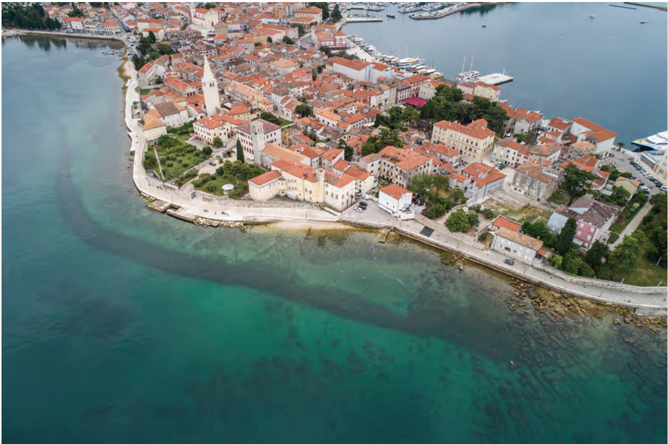
Sl. 24 Zračna snimka Porporele na sjevernoj strani grada Poreča, rezultati istraživanja u 2020. (fotografija: L. Damelet, CCJ-CNRS). Fig. 24 Aerial image of the Porporela structure to the north of Poreč; results of investigation in 2020 (photo: L. Damelet, CCJ-CNRS).
