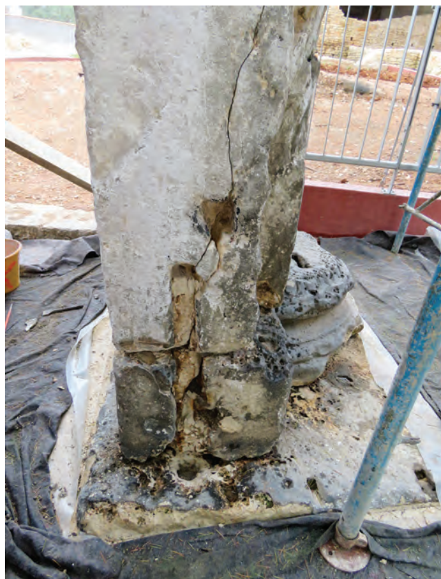
Sl. 11 Detalj pukotina i šupljina nakon odstranjivanja željeznih klinova i cementnih ispuna južnog pilastra (fotografija: Đ. Gobić-Bravar).
