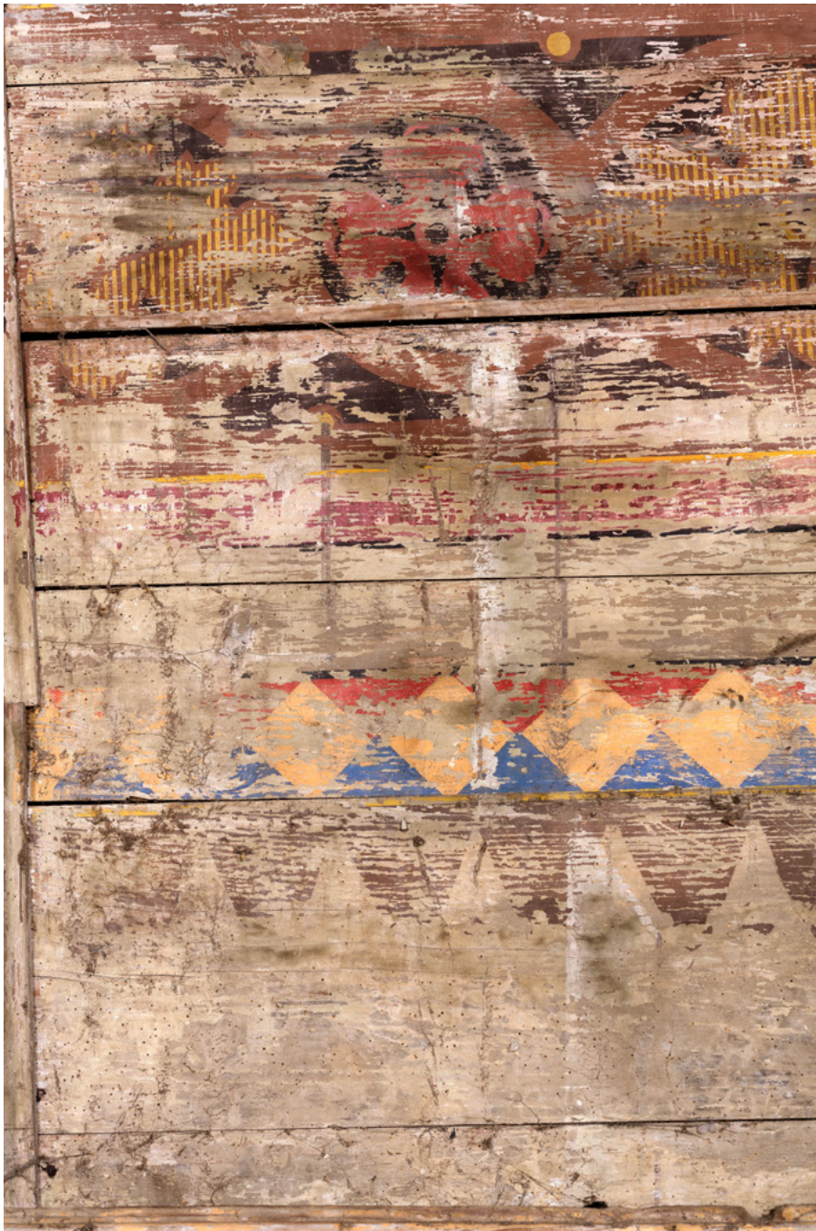
12. Detalj oslikane oplote svoda, detalj friza sa geometrijskim motivima, zatečeno stanje (arhiva HRZ-a, snimka: G. Tomljenović, 2016.) Detail of the painted panelling of the vault, detail of the frieze with geometric motifs before conservation (HRZ Photo Archive, G. Tomljenović, 2016)
