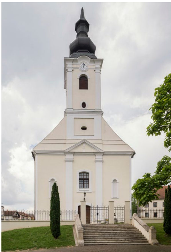
1. Lipovljani, župna crkva sv. Josipa, jugozapadno pročelje (arhiva HRZ-a, snimka: K. Gavrilica, 2023.) Lipovljani, parish church of St Joseph, southwest façade (HRZ Archive, K. Gavrilica, 2023)
