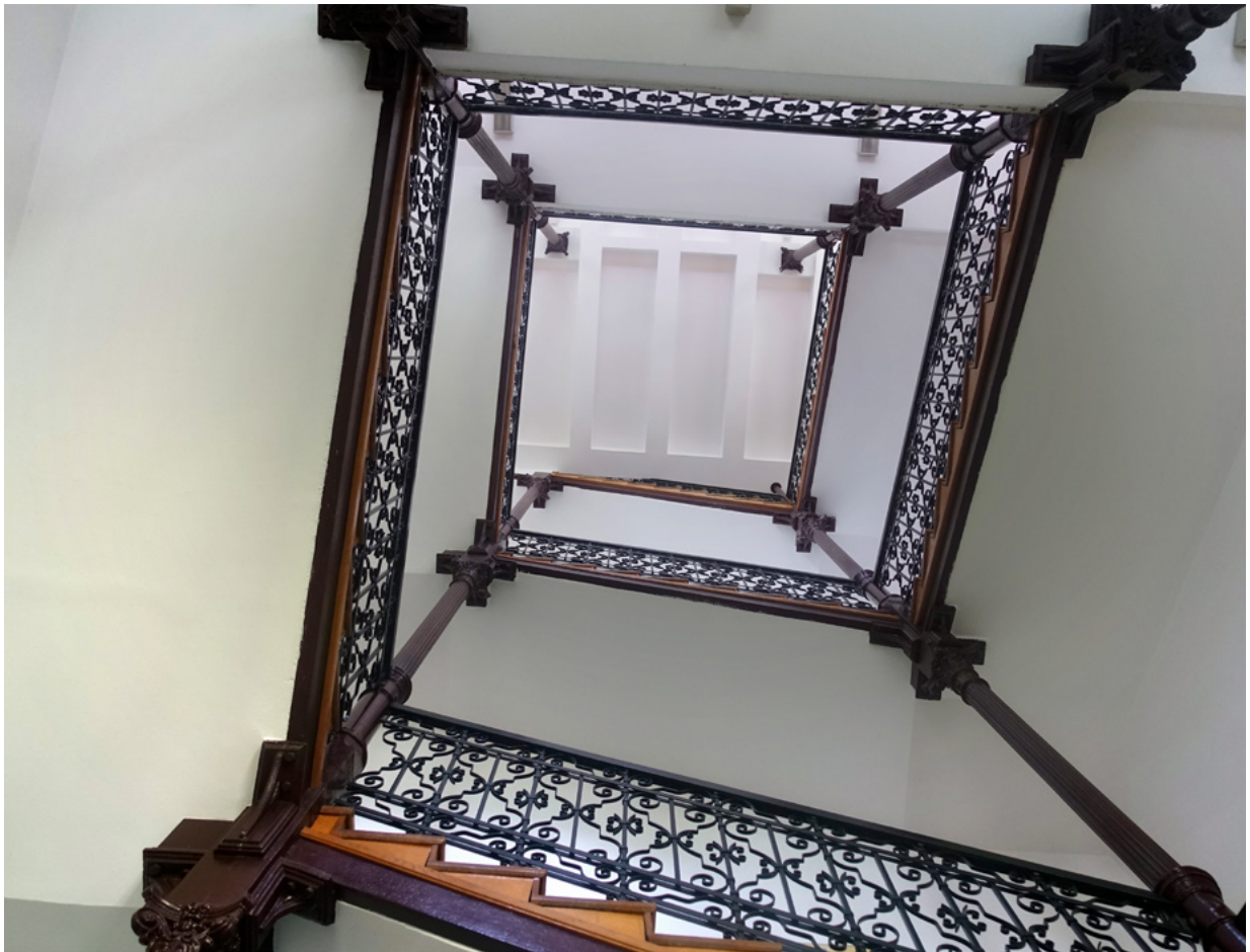
12. Reprezentativno južno stubište (snimka: M. Ivanuš, 2022.) Representative south staircase (M. Ivanuš, 2022)
