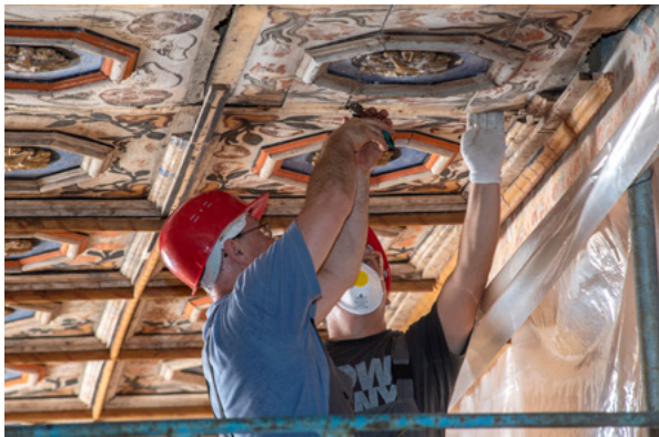
10. Demontaža drugog dijela tabulata (arhiva HRZ-a, snimka: J. Kliska, 2018.) Disassembly of the second part of the wooden ceiling (HRZ Archive, J. Kliska, 2018)
