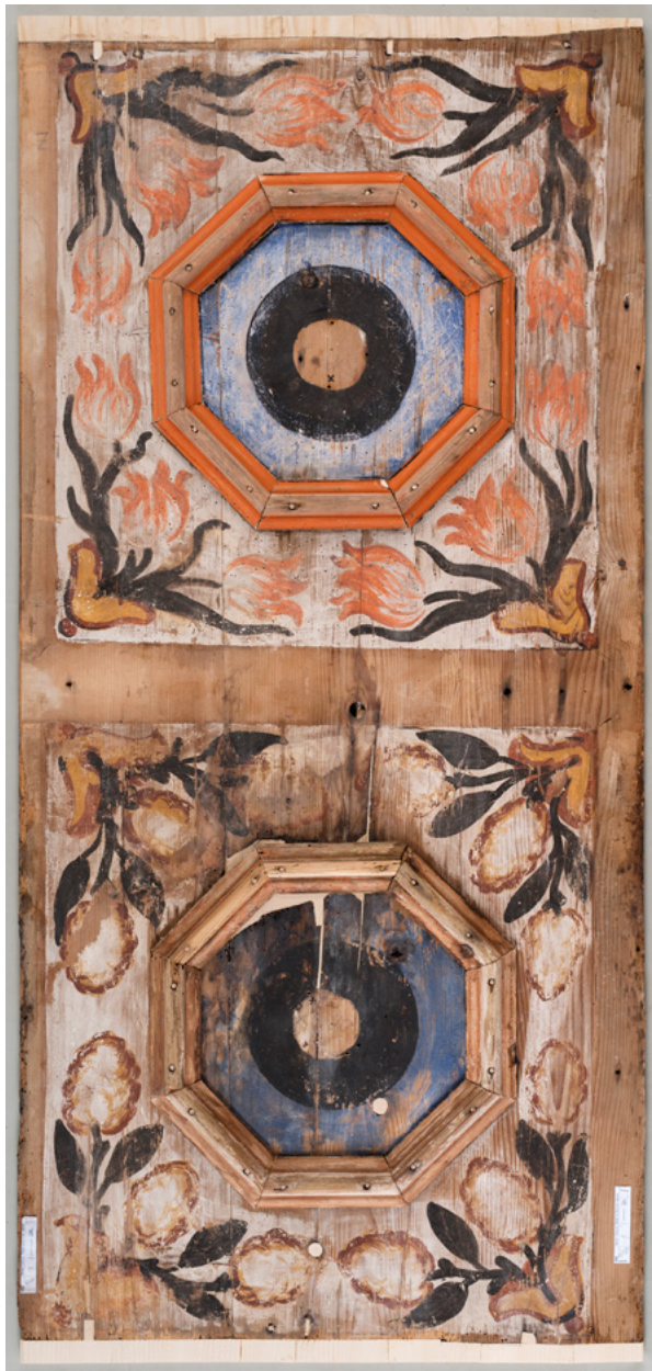
6. Kasete 19 i 20 nakon stolarske sanacije (arhiva HRZ-a, snimka: N. Oštarijaš, 2018.) Cassettes 19 and 20 after carpentry restoration (HRZ Archive, N. Oštarijaš, 2018)
