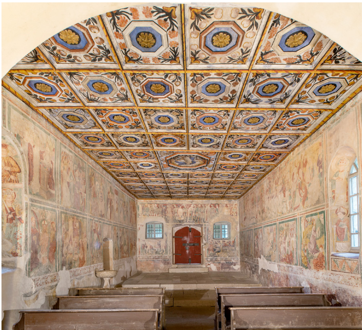
14. Pogled prema glavnom ulazu nakon montaže drugog dijela tabulata (arhiva HRZ-a, snimka: G. Tomljenović, 2020.) View towards the main entrance after the return of the second part of the wooden ceiling (HRZ Archive, G. Tomljenović, 2020)
