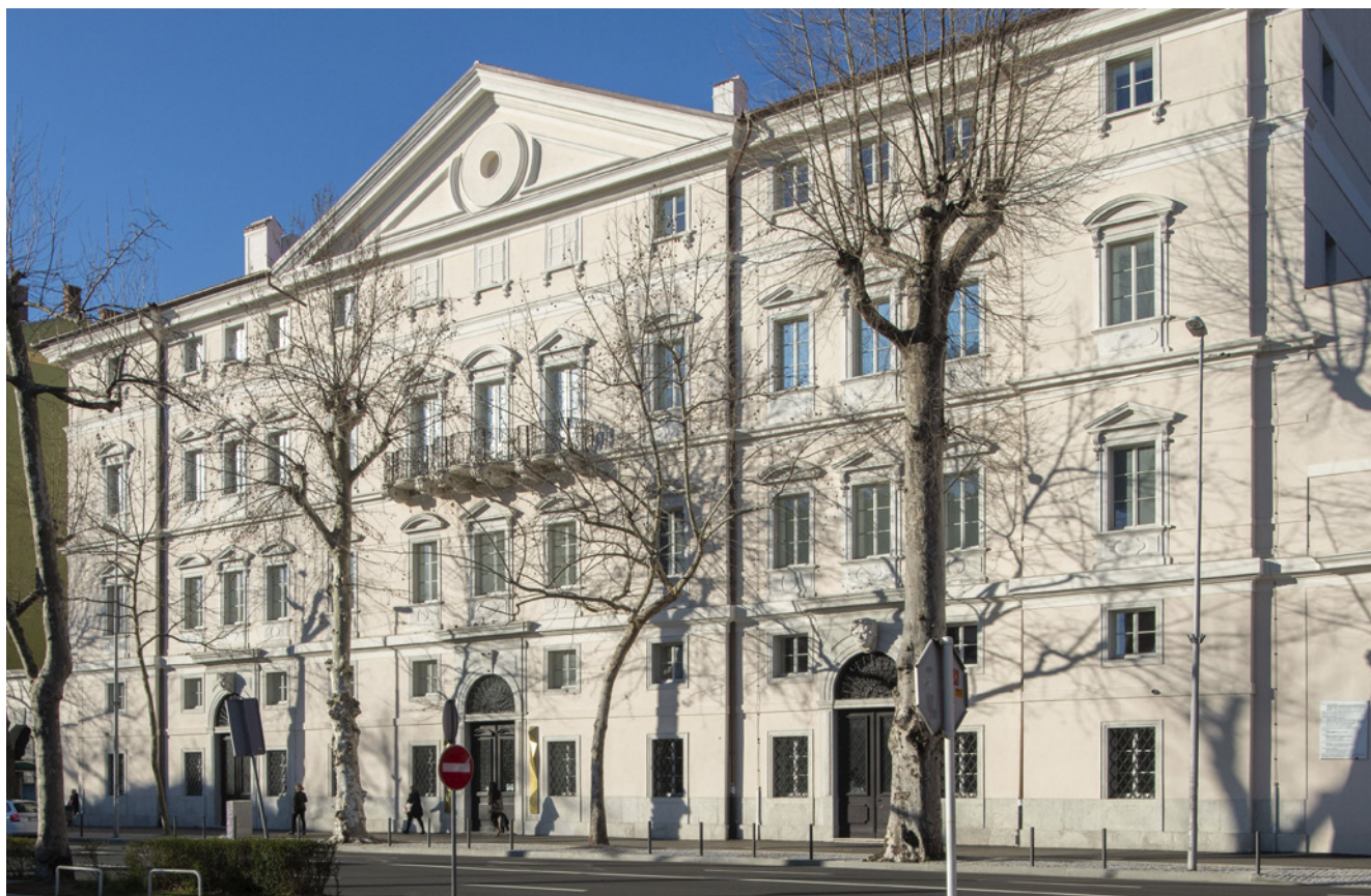
1. Rijeka, palača šećerane, pročelje (foto: J. Kliska, 2021.)
