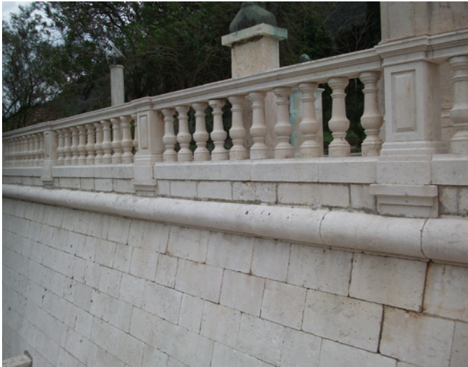
22. Pogled na potporni zid i balustradu terase, 2013. (foto: Anton Gula Marković)
