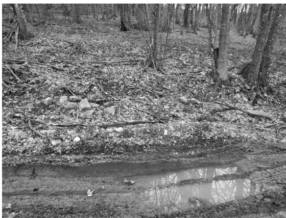
Slika 6. Radovima izmaknuto originalno kamenje rimske ceste (foto: N. Turkalj)
