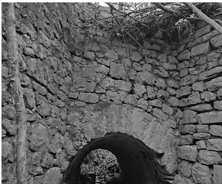
Slika 10. Visina mosta od 5 metara za premostiti vododerinu je previše neobična za obični šumski put (foto: N. Turkalj)
