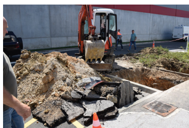
Slika 6. Radovi na iskopavanju kabela
