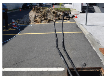
Slika 7. Kablovi nakon vađenja iz kanala
