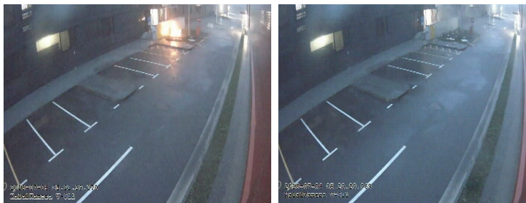
Slika 1. Snimke eksplozije u prostoriji s razvodnim ormarima i u šahtu s kabelima
