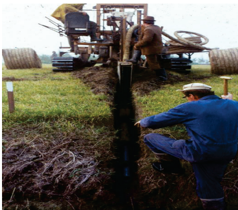
Slika 12. Cijevne drenaže Picture 12 Pipe drainage (Foto Vidaček)
