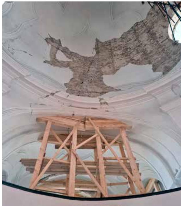
16 Preventivne mjere stabilizacije konstrukcije zaštićenih spomenika kulture: crkva sv. Marije Magdalene u Selima (Baza HCPI, fotografije oštećenja građevina, 2020.)
