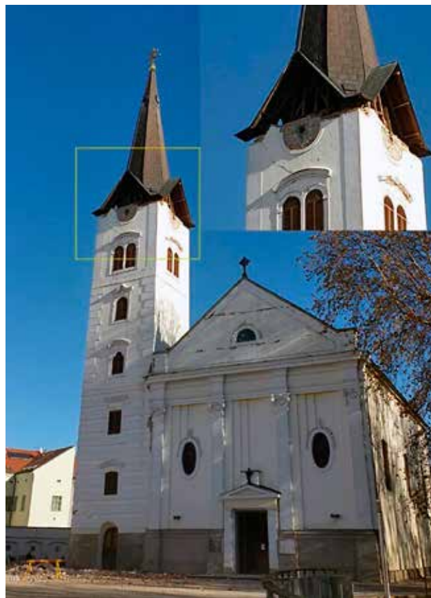
17 Oštećenja katedrale Uzvišenja Svetog Križa u Sisku (Baza HCPI, fotografije oštećenja građevina, 2020.)
