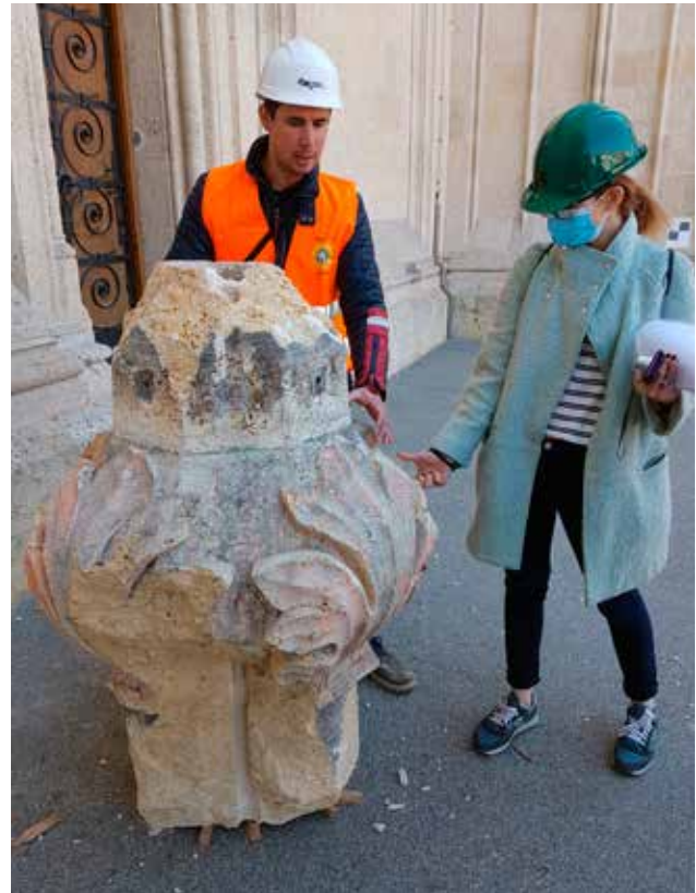
4 Zagreb, Katedrala Uznesenja BDM, popisni tim Gradskog zavoda za zaštitu spomenika kulture i prirode Grada Zagreba u pregledu oštećenja (foto: GZZSKP, 2020.)
