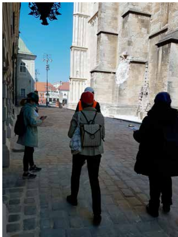
2 Zagreb, Katedrala Uznesenja BDM, popisni tim Gradskog zavoda za zaštitu spomenika kulture i prirode Grada Zagreba u pregledu oštećenja (foto: Gradski zavod za zaštitu spomenika i prirode – dalje GZZSKP, 2020.)
