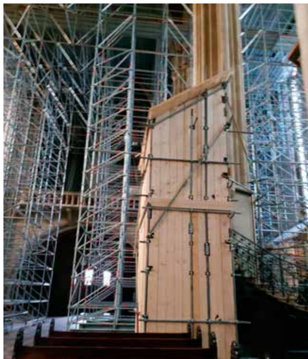
11 Zagreb, mjere zaštite inventara drvenim oplatama i zaštitnim skelama na primjeru katedrale Uznesenja Blažene Djevice Marije i svetih Stjepana i Ladislava (foto: T. Horvatić, MKM, 2021.)
