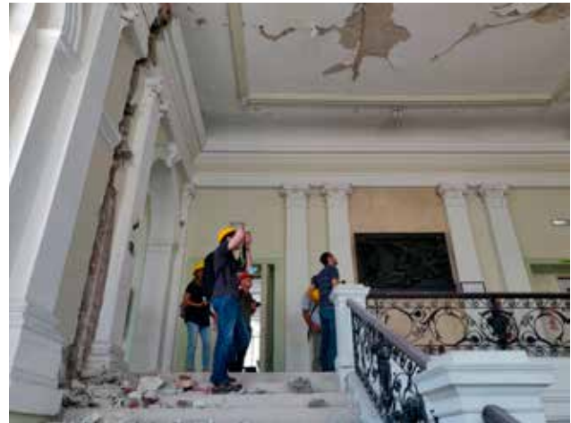
6 Obilazak zgrade Pravnog fakulteta i Rektorata Sveučilišta u Zagrebu tijekom studijskog posjeta stručnjaka za potresno inženjerstvo sa Sveučilišta u Portu u srpnju 2021. godine (foto: P. Smajić, MKM, 2021.)
