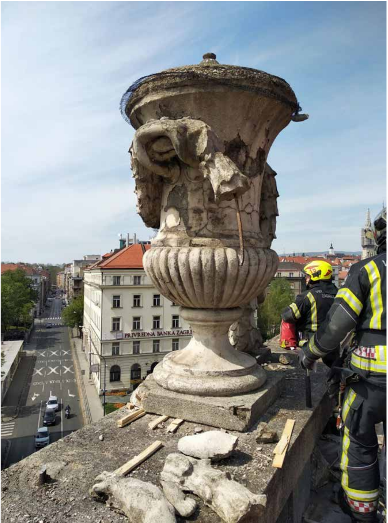
1 Vatrogasna postrojba u suradnji s Gradskim zavodom prije skidanja ukrasne vaze s krova zgrade Račkoga 9 (fototeka Gradski zavod za zaštitu spomenika kulture i prirode, dalje - GZZSKP 2020.)
