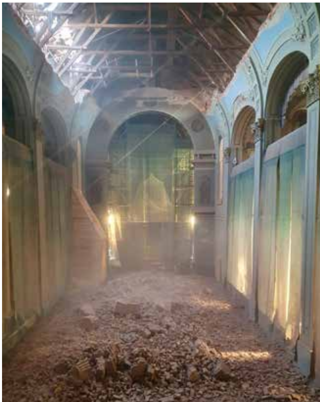
15 Bazilika Srca Isusova u Palmotičevoj neposredno nakon razgradnje svoda (fototeka GZZSKP, 2021.)
