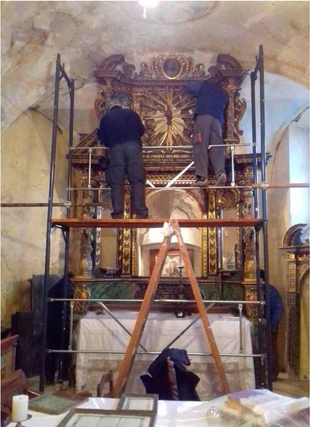
21 Demontaža atike glavnog oltara u kapeli sv. Mihalja u Vugrovcu (fototeka GZZSKP, 2020.)
