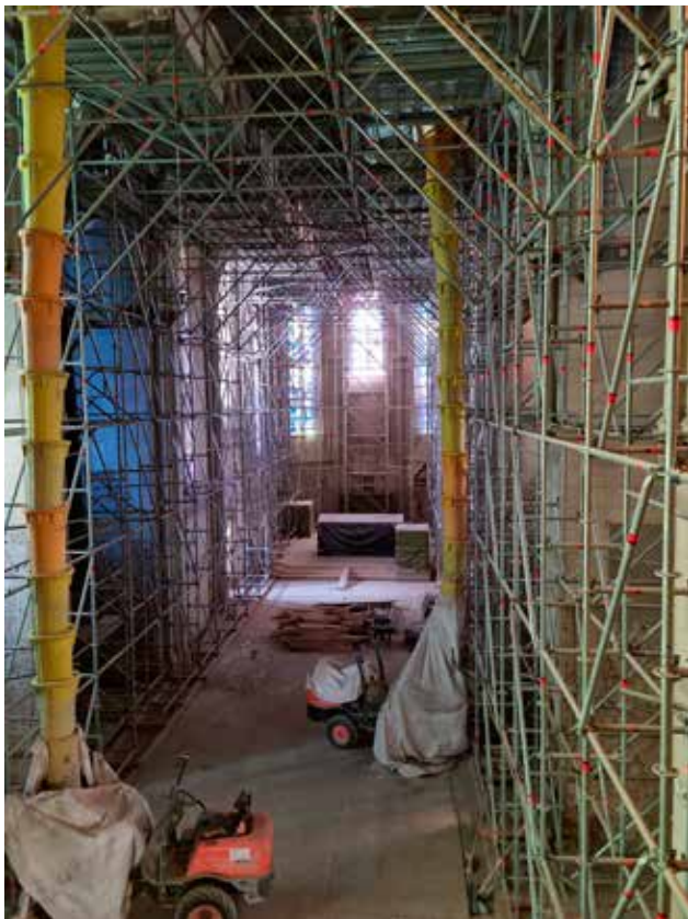
12 Podupiruća skela u unutrašnjosti crkvi sv. Franje Asiškog na Kaptolu (fototeka GZZSKP, 2021.)
