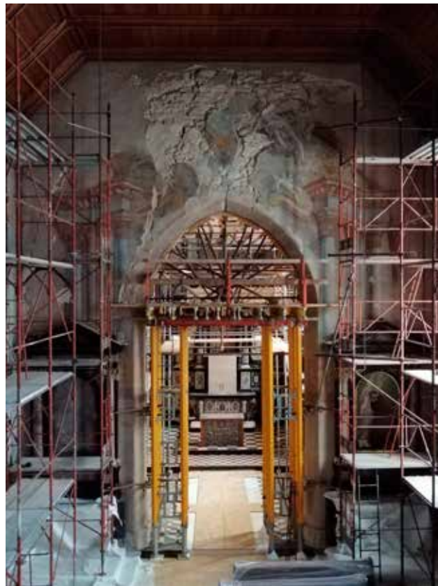
13 Podupiranje triumfalnog luka u crkvi Uznesenja Blažene Djevice Marije u Remetama (fototeka GZZSKP, 2020.)
