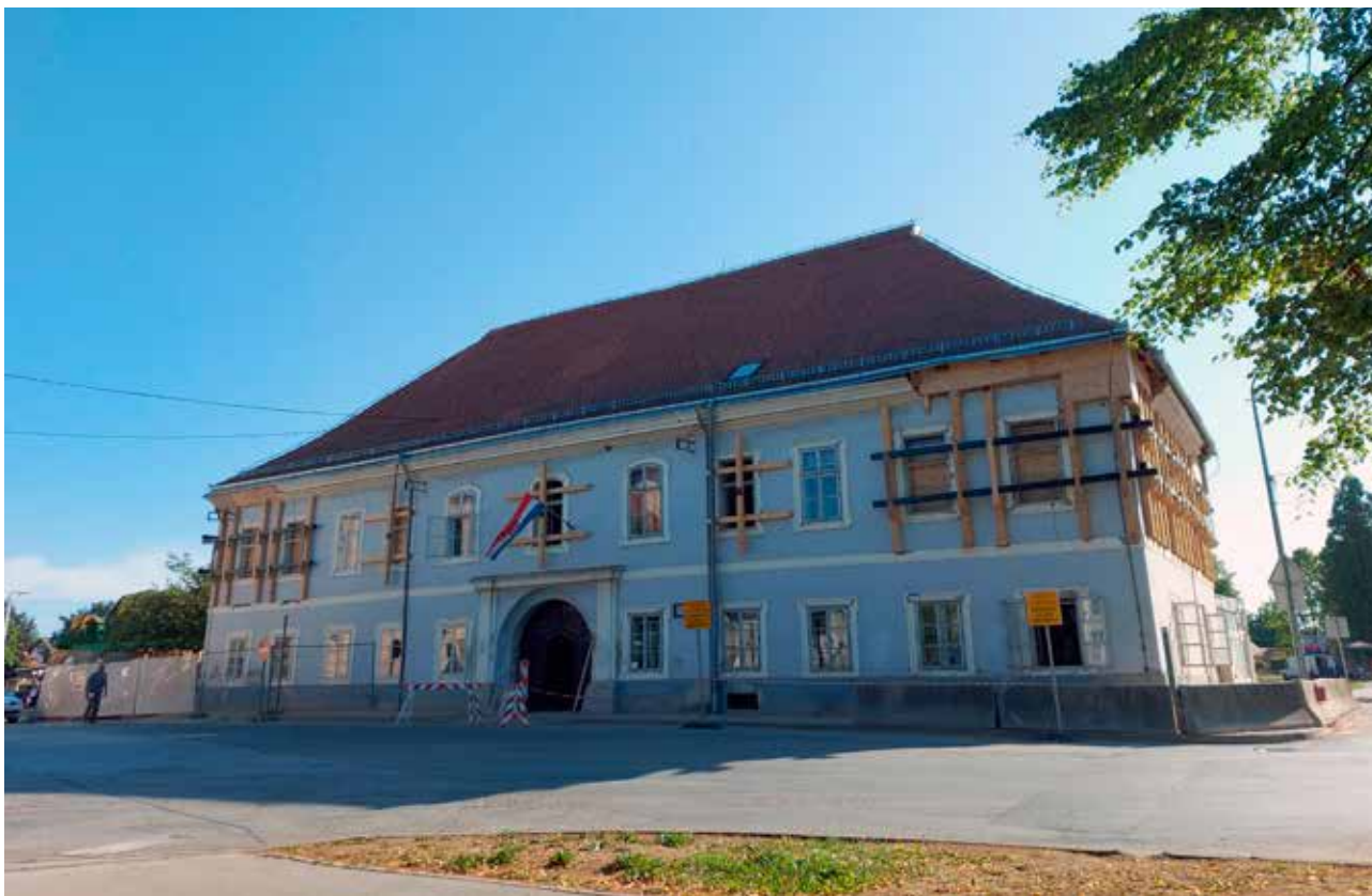
19 Petrinja, provedba mjera zaštite na zgradi Suda, Trg F. Tuđmana 12 (foto: I. Miletić Čakširan, KO SK, 2021.)
