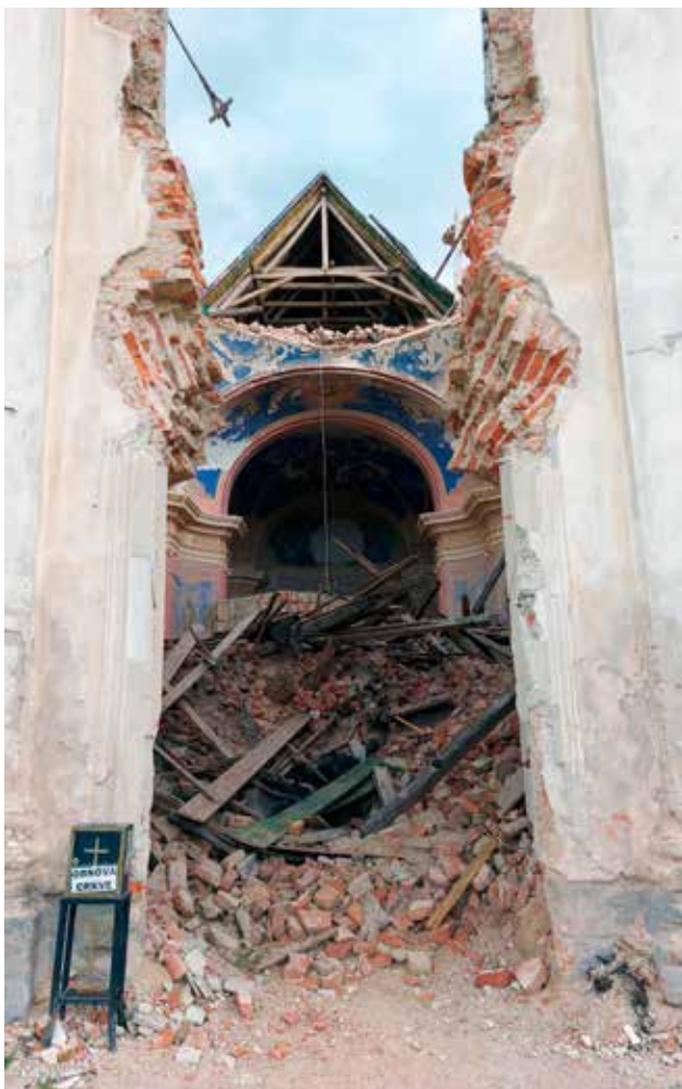
13 Žažina, crkva sv. Nikole i Vida, razina oštećenja (foto: I. Miletić Čakširan, KO SK, 2021.)
