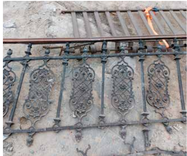
21 Pohrana dekorativnih elemenata zgrada prilikom uklanjanja (foto: I. Miletić Čakširan, KO SK, 2021.)
