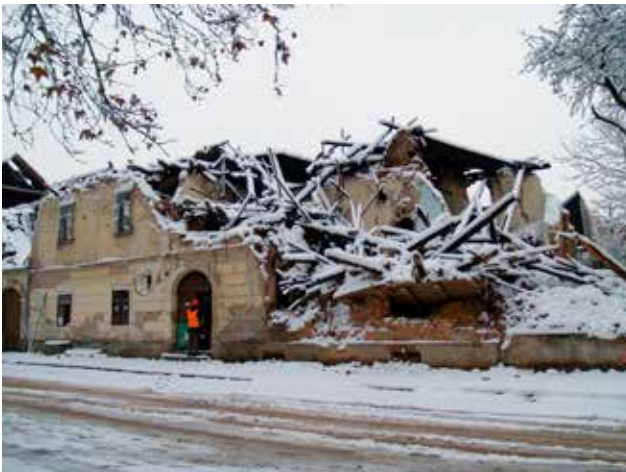
1 Petrinja, razorno oštećenje zgrade Trg F. Tuđmana 1 (foto: T. Petrincec, Ministarstvo kulture i medija – dalje MKM, 2021.)
